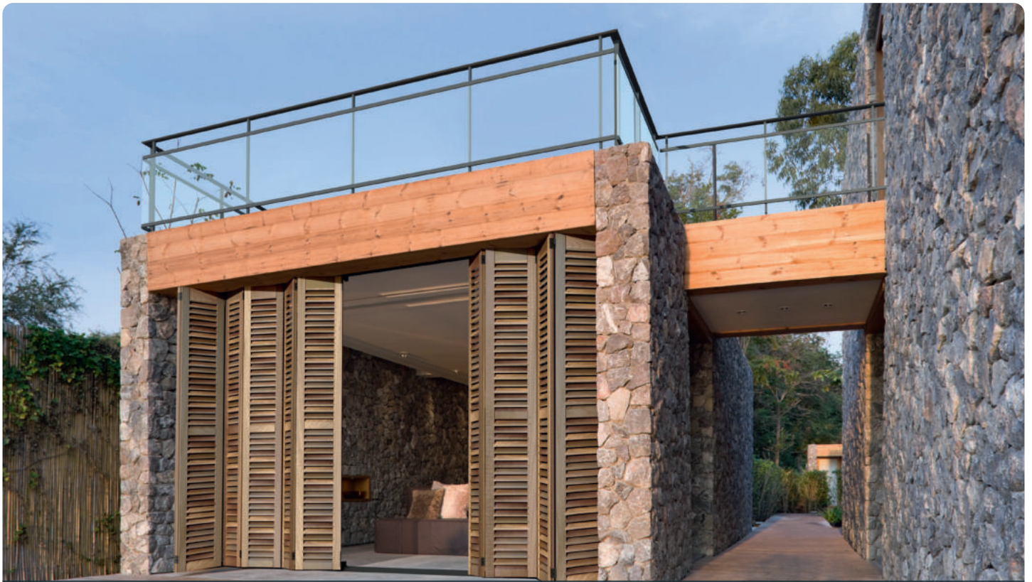
Volets coulissants-pliants à cadre en bois 6 et 4 vantaux lames persiennes ajourées à la française affleurantes, essence exotique au naturel – Garde-corps alu soudé et remplissage verre (modèle 12 AluConcept). Coloris : noir foncé RAL 9005.
