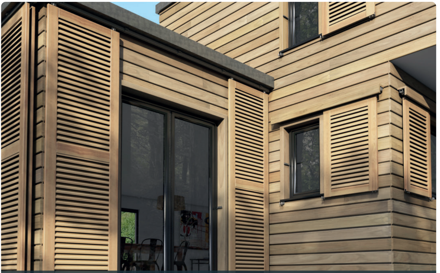
Volets coulissants à cadre en bois, fenêtre et porte-fenêtre lames persiennes jointives à la française – Essence de bois pin/épicéa abouité.
