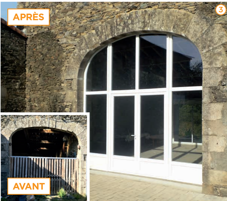
1 et 2. Rénovations ALUMINIUM. 3. Porte-fenêtre en PVC en anse de panier avec imposte fixe. 4. Rénovation BOIS.
