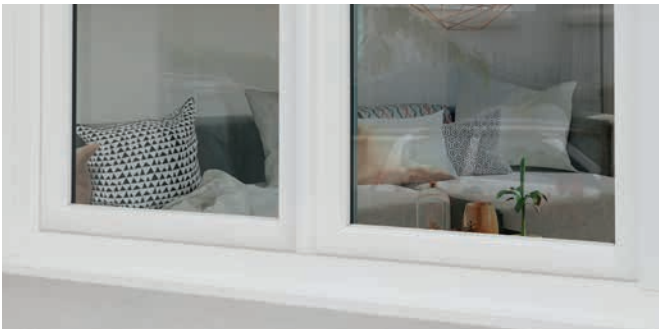
Fenêtre 2 vantaux, vue de l'extérieur.
