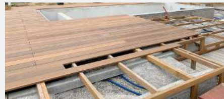
Pose sur structure maçonnerie
